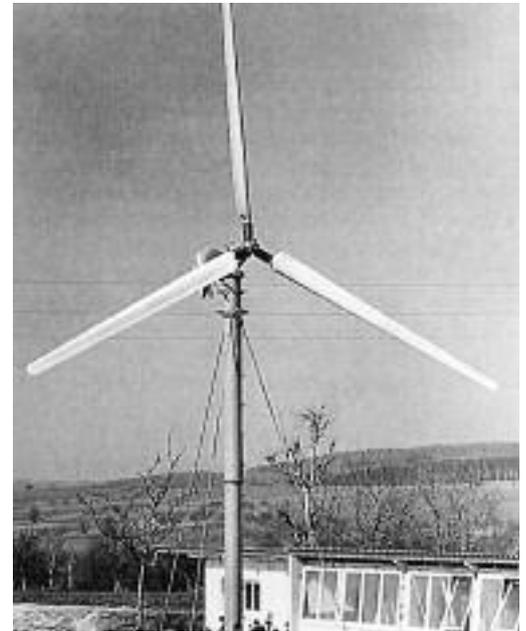
*Ein Dreiblatt-Rotor, Seitenrad, Dreibein-Rohrturm, ein bißchen Regelung – das war der Urtyp aller Windkraft-Anlagen (links). Allgaier WE 10 Anlage mit einfachem, verspanntem Rohrmast (rechts).*
