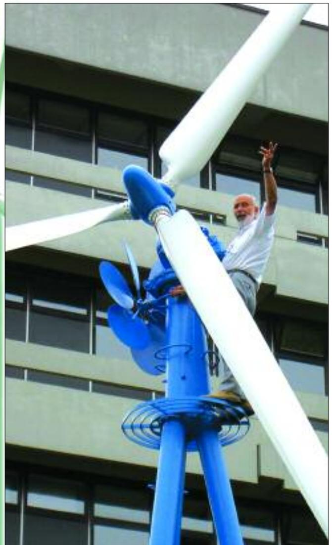
*Denkmal für den Windenergie-Pionier: Die historische Windenergie-Anlage (Typ Allgaier-Hütter WE 10/G6, Baujahr 1949) des Instituts für Flugzeugbau der Universität Stuttgart wurde 2003 eingeweiht.*
